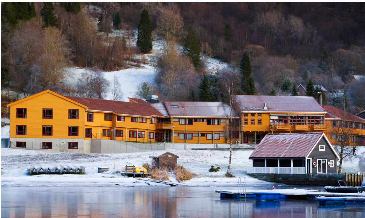
Den nye pasientfløyen er bygd på nordsida av hovudbygningen. . Den nye fløyen er til venstre.
